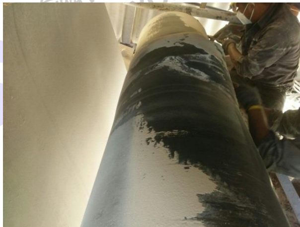
การหุ้มเย็นที่หน้างานลูกพู่เลย์จะต้องสะอาดปราศจากฝุ่น
