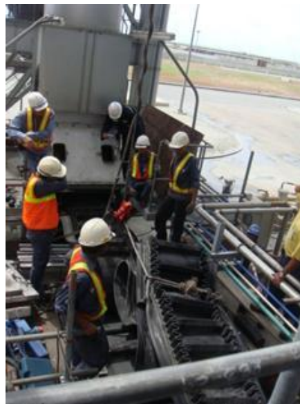
Sidewall Beltขณะทำการติดตั้ง
